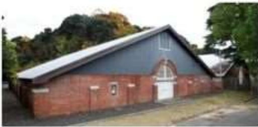
北吸配水池 (舞鶴旧海軍鎮守府水道施設) ※外観のみ公開
