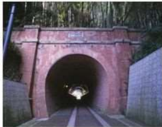
市道北吸・桃山線北吸トンネル (舞鶴旧海軍鎮守府軍港引込線北吸隧道) ※常時公開
