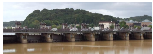
写真 3.3.1-1 瀬田川洗堰全閉操作(平成 25 年台風 18 号)
